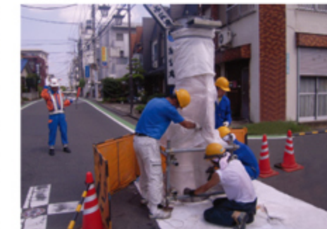
マンホール施工中
