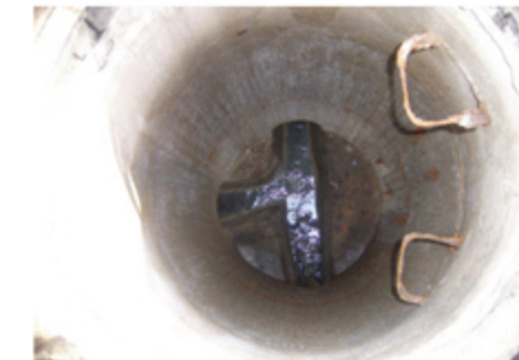
マンホール施工前
