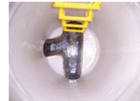
マンホール施工後
